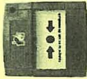
Le déclencheur manuel permet de déclencher l'alarme en pressant sur une membrane déformante ou en brisant la vitre protectrice. Il doit être placé à 1,30 m du sol, à proximité de chaque issue et des escaliers, au rez-de-chaussée et à chaque étage dans les espaces de circulation.
